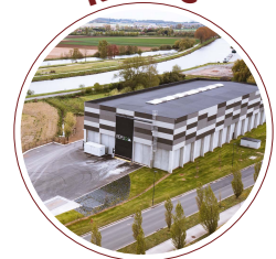
Centre de recyclage du plâtre
